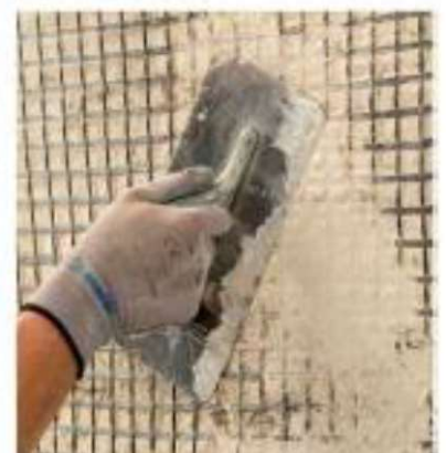
Ugradnja FRCM sustava
