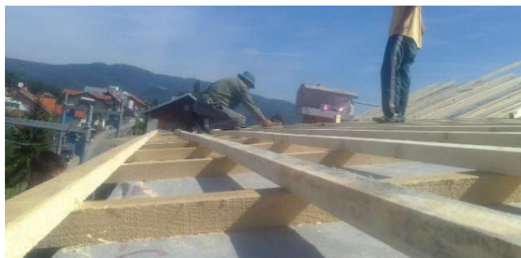
Slika 47. Letve i kontraletve na foliji
