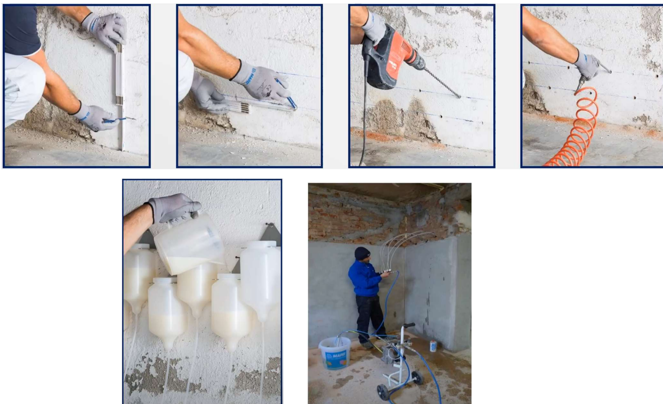
Slika 43. Izvedba kemijskog prekida kapilarne vlage
