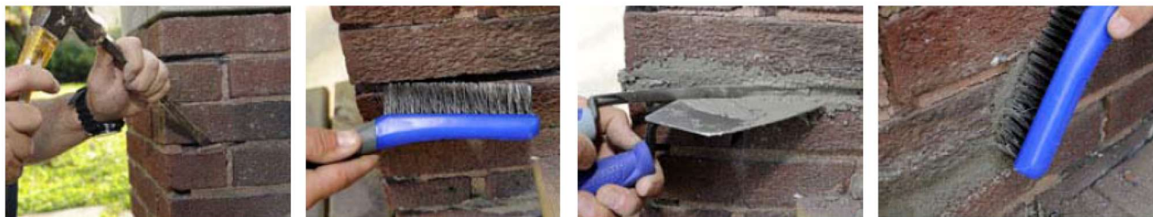
Slika 30. Djelomična zamjena morta u sljubnicama
