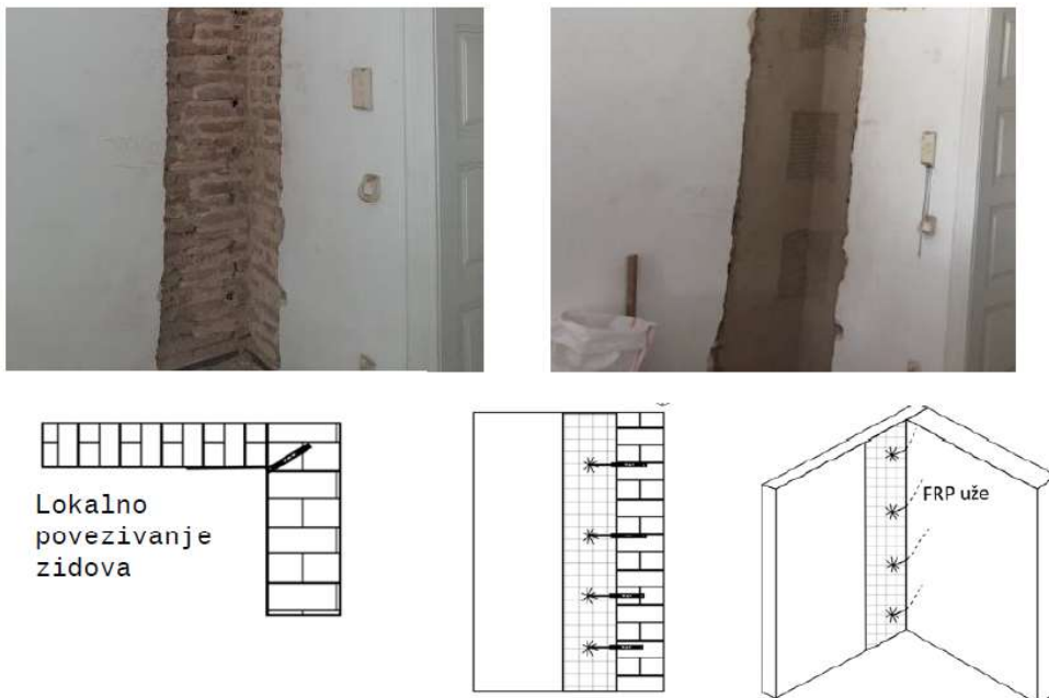
Slika 35. Sanacija spoja nosivih zidova
