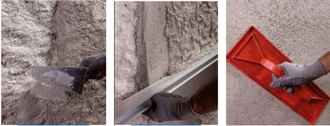
Slika 45. Nanošenje isušujuće žbuke preko temeljne žbuke
