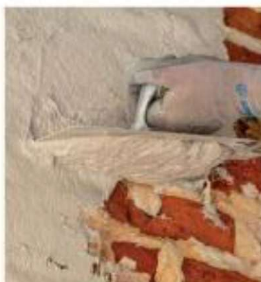
Žbukanje reparaturnim mortom
