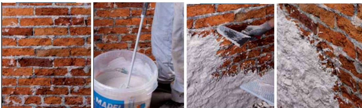
Slika 44. Proces nanošenja temeljne žbuke
